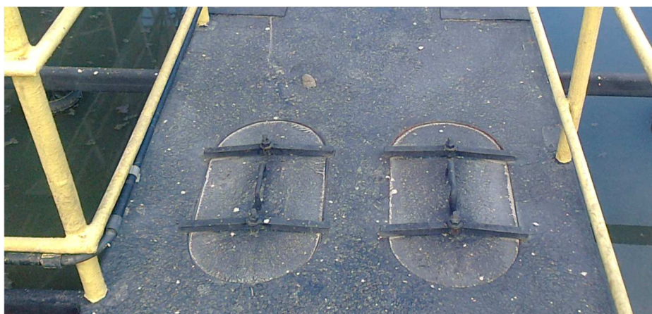
Figura 9. Tampa da boca de visita da câmara de gás – modelo Sanevix.
