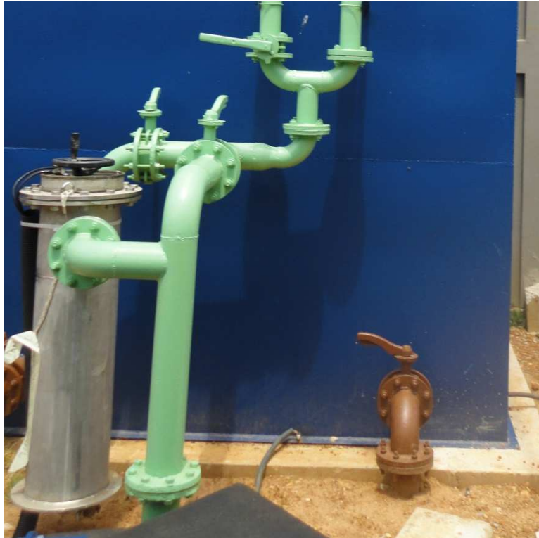
Figura 20. Reator ultravioleta da estação.
