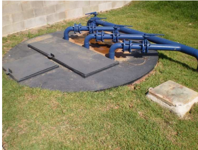
Figura 6. Modelo de Estação Elevatória de Esgoto (EEE) da Sanevix, constituído de 3 bombas.
